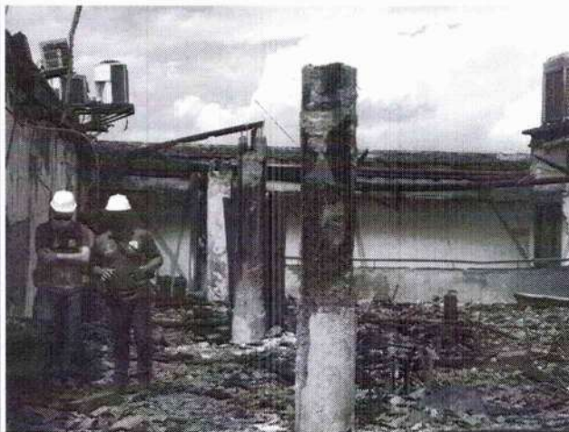
Figura 63 - Colunas com a face voltada para a frente do fogo.
