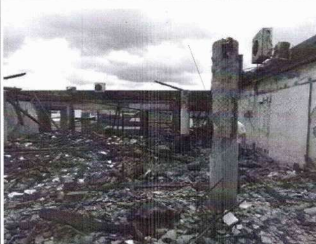
Figura 65 - Colunas indicando a face voltada para o sentido contrário de propagação do fogo.
