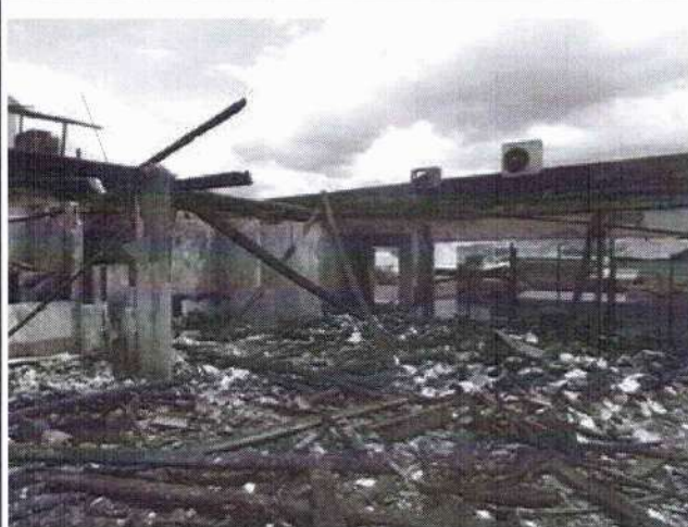
Figura 64 - Colunas indicando a face voltada para o sentido contrário de propagação do fogo.
