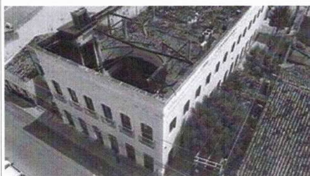
Figura 29 - Visão geral da região superior do imóvel.
