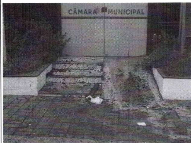
Figura 9 - Porta de acesso ao imóvel.
