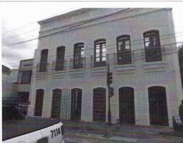
Figura 19 - Fachada posterior do imóvel.
