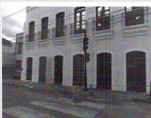
Figura 20 - Visão geral da parte externa do imóvel.
