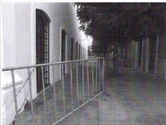
Figura 27 - Fachada angular ao imóvel.
