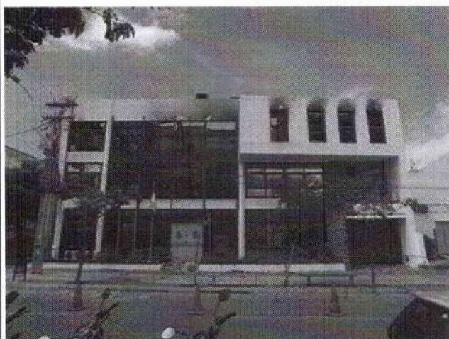
Figura 7 - Visão geral da parte externa do imóvel.
