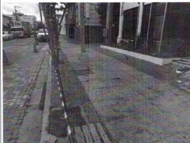
Figura 10 - Visão geral da parte externa do imóvel.
