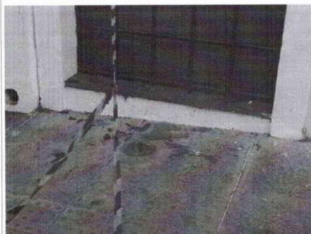
Figura 25 - Vidros oriundos das portas de acesso ao imóvel, pela região posterior do imóvel.
